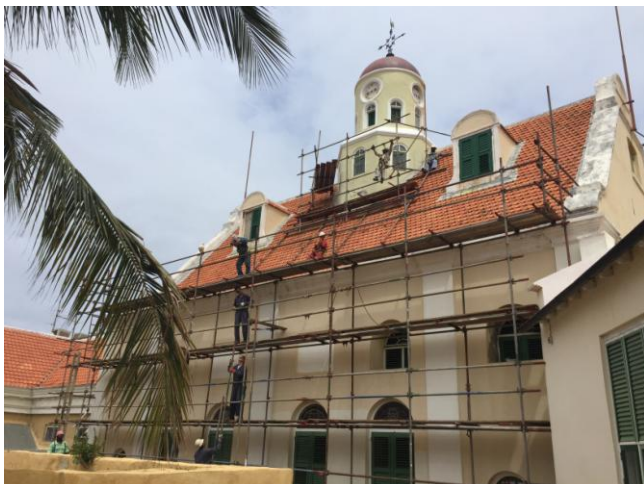
Fortkerk in de steigers met het karakteristieke torentje
